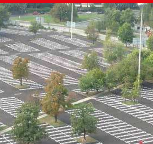
Stadio Meazza Milano - Asfaltatura e segnaletica
