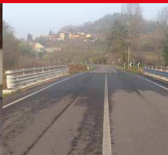
Moasca (AT) SP 6 Realizzazione ponte
