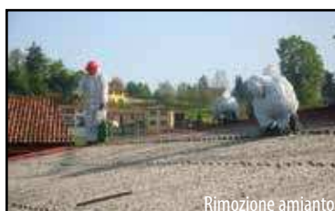
Rimozione amianto
